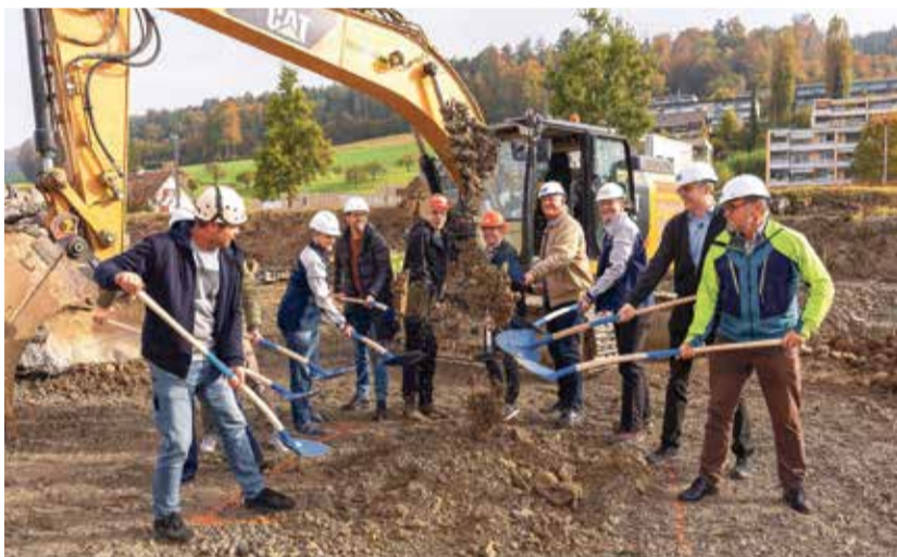
An der Bollstrasse haben die Bauarbeiten nun begonnen. Bild: S. Mathys
