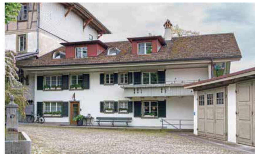
Dachstock auf dem Areal der Schlossmühle. 2012 liess die Familie Aeberhard den Dachstock des Wohnhauses an der Mühlestrasse 35 dendrochronologisch untersuchen. Dabei stellte sich heraus, dass dieser um 1856 erbaut wurde, wobei auch hier wie beim Bürgenstock ältere Hölzer verwendet wurden, so der Riegständer von 1811. Bild: S. Mathys
