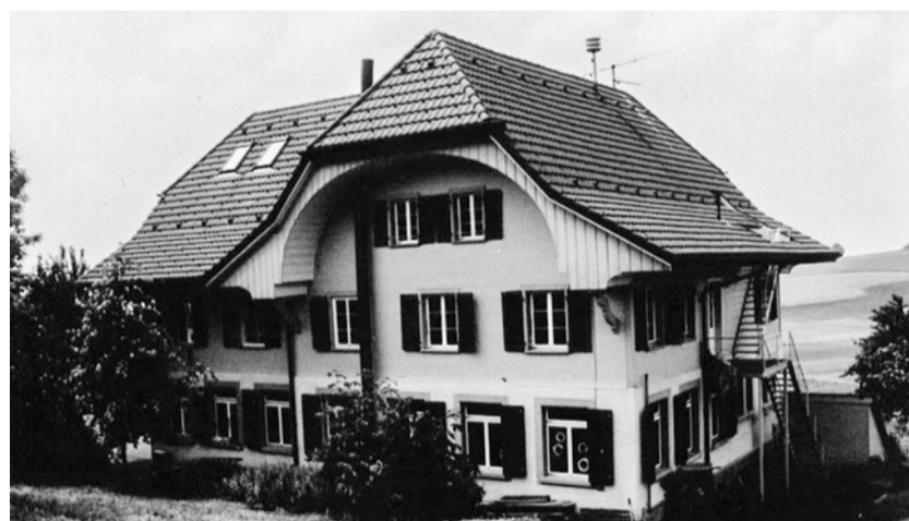
Das Schulhaus Wattenwil-Bangerten, das 1924 eingeweiht wurde. Bild: Bilddatenbank IG Worber Geschichte
