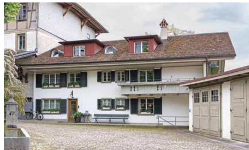
Dachstock auf dem Areal der Schlossmühle. 2012 liess die Familie Aeberhard den Dachstock des Wohnhauses an der Mühlestrasse 35 dendrochronologisch untersuchen. Dabei stellte sich heraus, dass dieser um 1856 erbaut wurde, wobei auch hier beim Birgenstock ältere Hölzer verwendet wurden, so der Riegständer von 1811. Bild: S. Mathys
